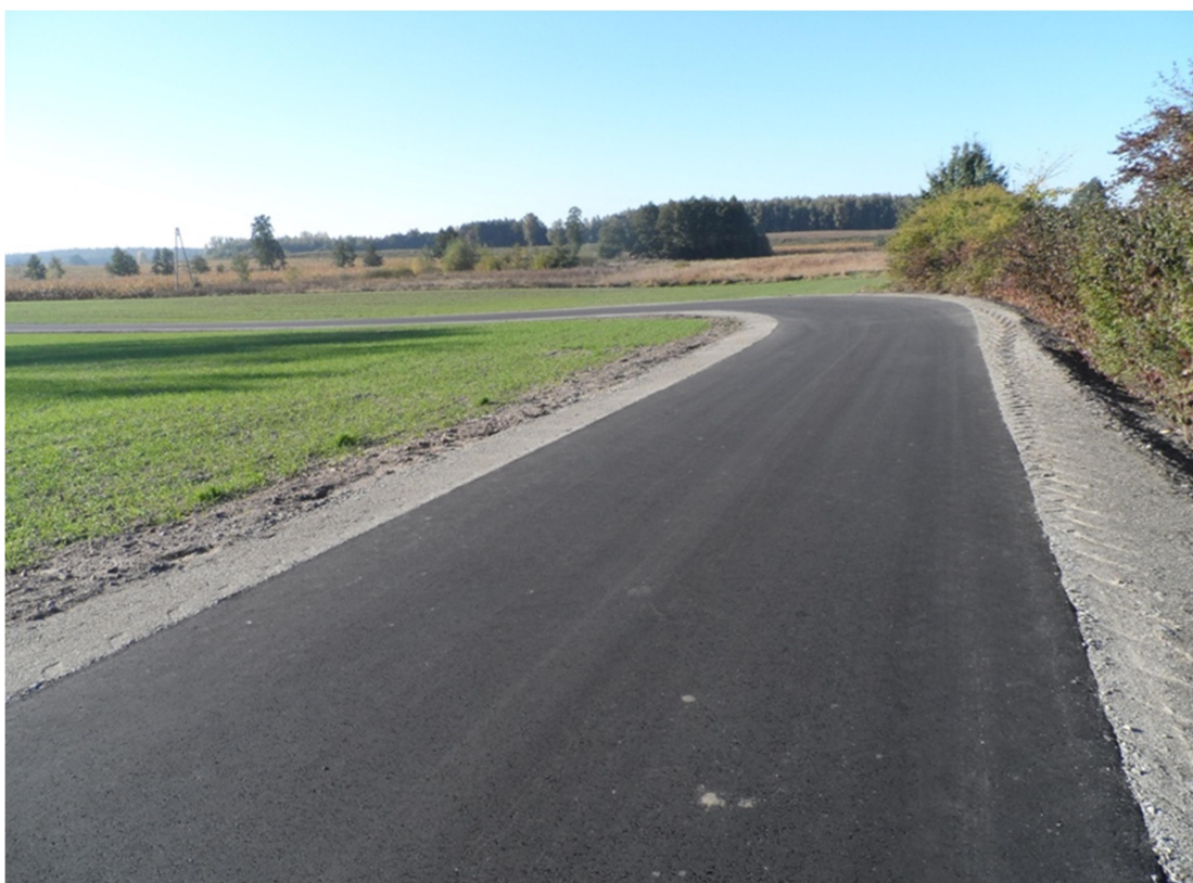
Przebudowa drogi gminnej w miejscowości Lubomin Rządowy opracowanie własne Zdzisława Bywalska
