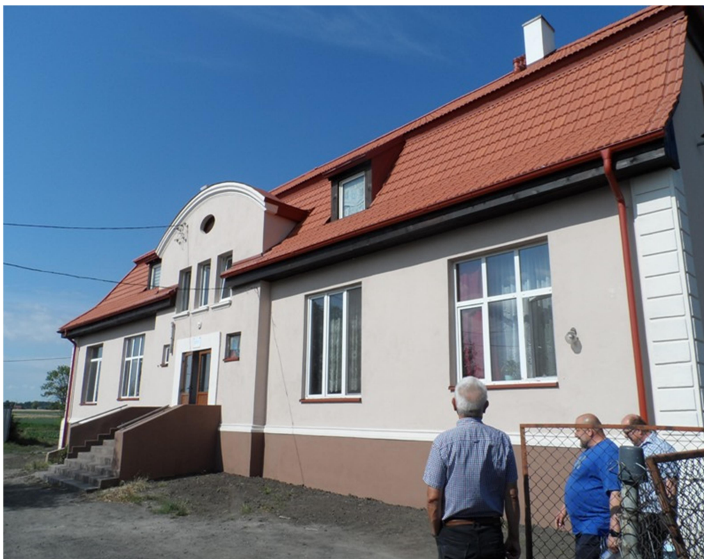
Opracowanie własne Zdzisława Bywalska -realizacja II części zadania Remont/modernizacja budynku komunalnego w m. Kaniewo
