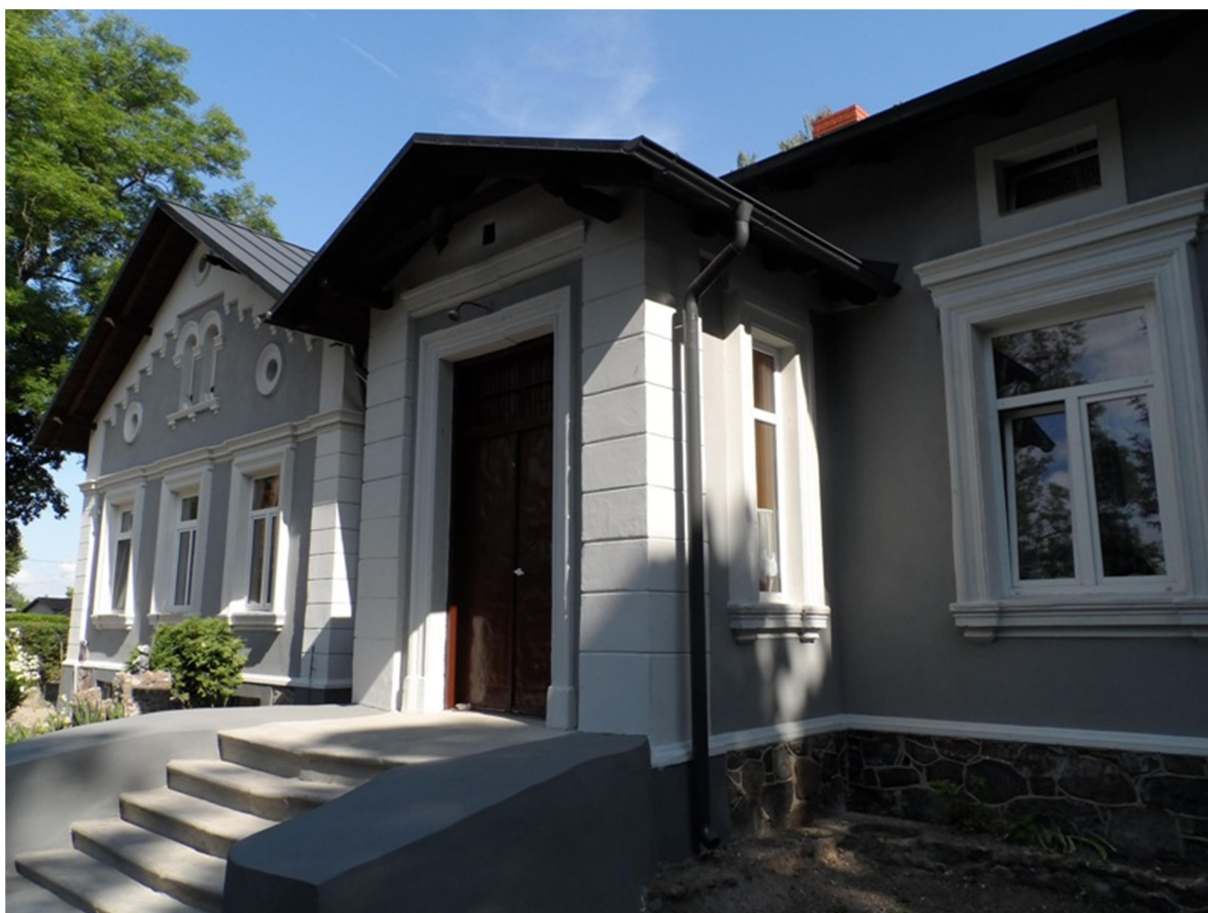
Opracowanie własne Zdzisława Bywalska -realizacja II części zadania Remont/modernizacja budynku komunalnego w m. Boniewo ul. Parkowa
