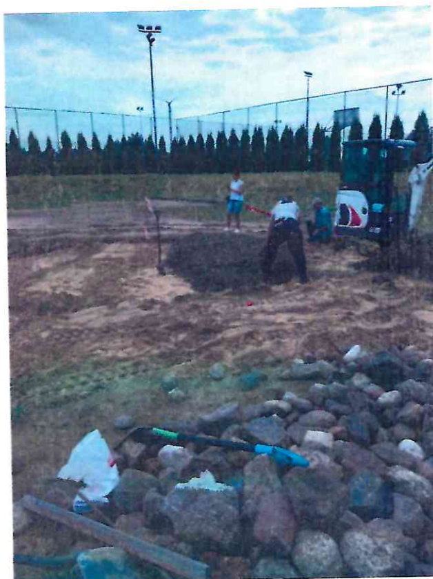
Opracowanie własne rozpoczęte prace
