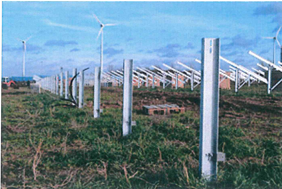
Zdjęcie 1. Profile metalowe: podstawowy element konstrukcji.
