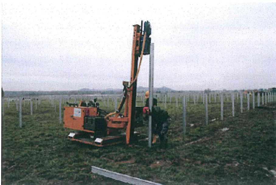
Zdjęcie 2. Montaż profili za pomocą kafara.
