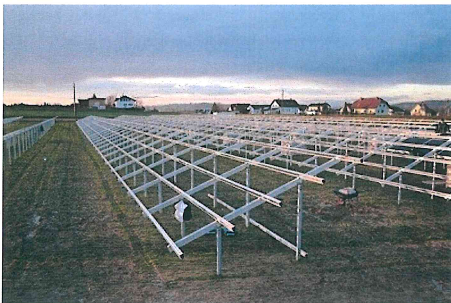
Rysunek 4. Szkielety przed montażem paneli, farma solarna NIENBURG 4 MW (Niemcy) (Remor Solar)
