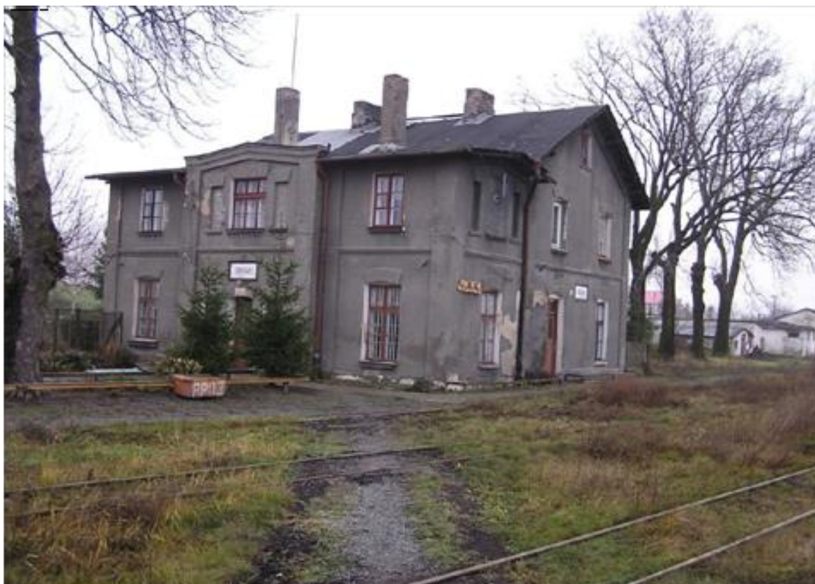
Źródło: opracowanie własne, budynek stacji PKP
