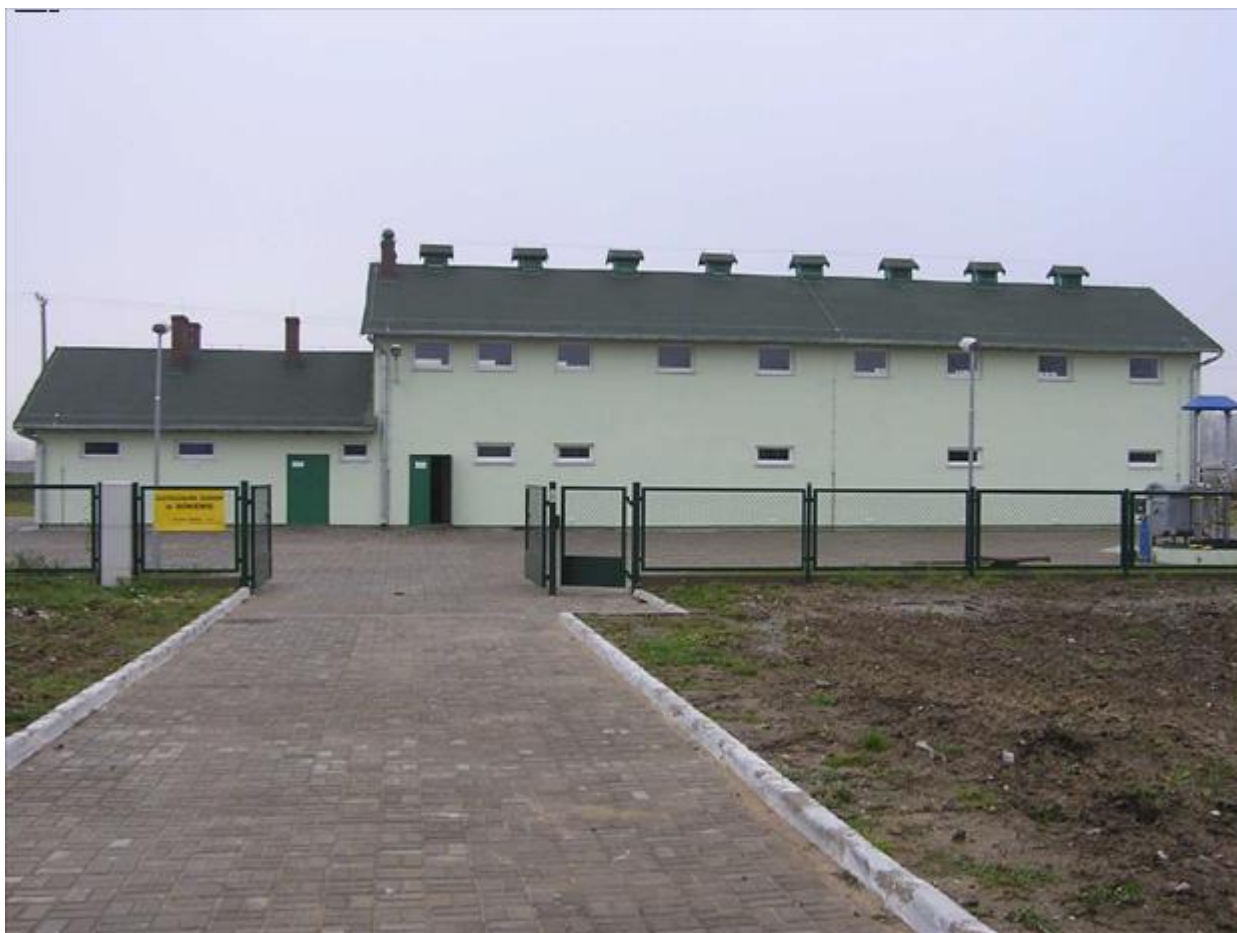
Gminna oczyszczalnia ścieków, opracowanie własne
