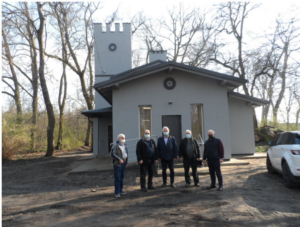
Opracowanie własne – świetlica Osiecz Wielki
