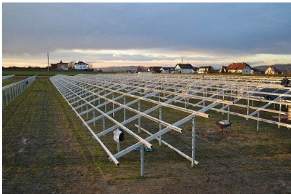
Rysunek 5. Szkielety przed montażem paneli, farma solarna NIENBURG 4 MW (Niemcy) (Remor Solar).
