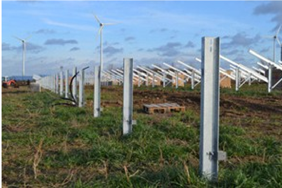
Zdjęcie 1. Profile metalowe: podstawowy element konstrukcji.
