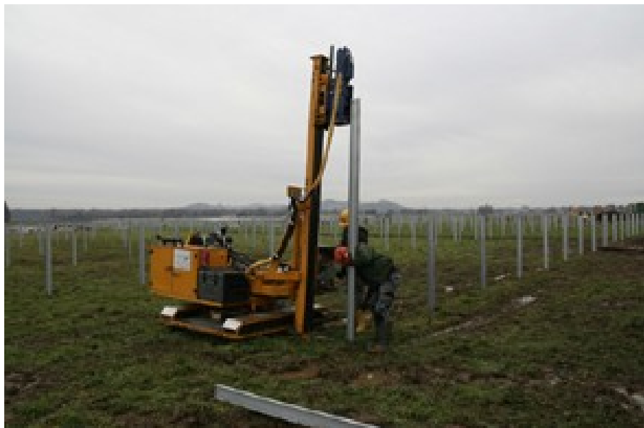
Zdjęcie 2. Montaż profili za pomocą kafara.
