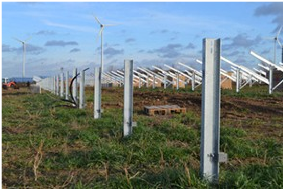
Zdjęcie 1. Profile metalowe: podstawowy element konstrukcji.
